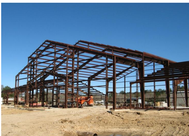
2009 年底凯地新堂建筑工地
